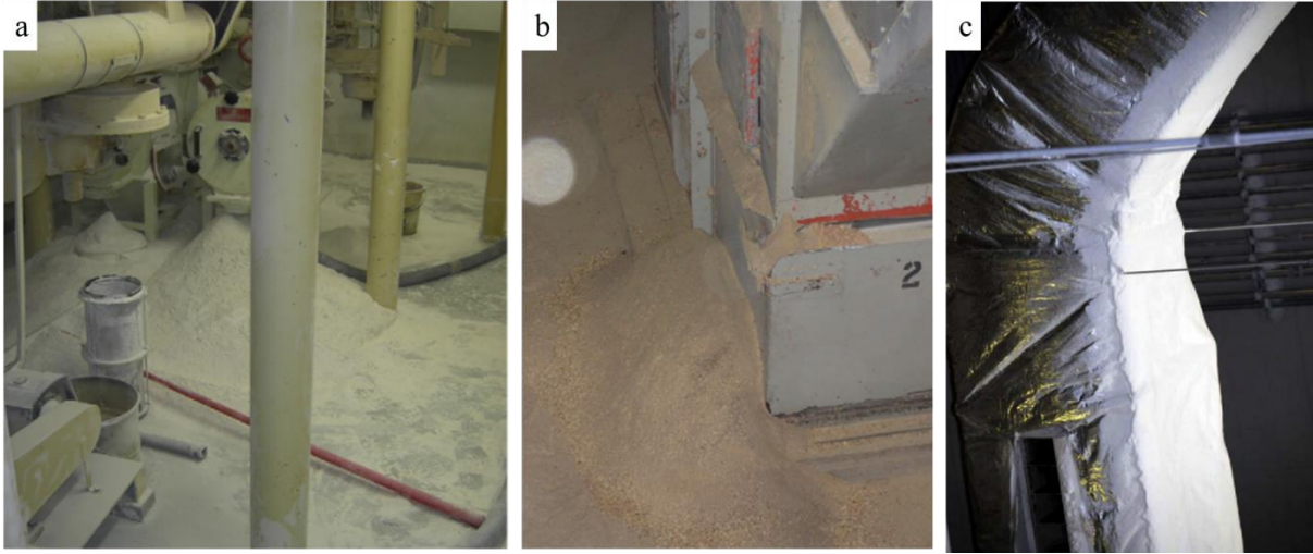
Şekil 4. Silo altında (a) ve proses ekipmanından aşırı malzeme sızması nedeniyle toz tabakası birikmesi (b), kanallar, kirişler, kablo kanalları vb. yükseltilmiş, yatay yüzeylerde toz birikmesi (c) [42]
